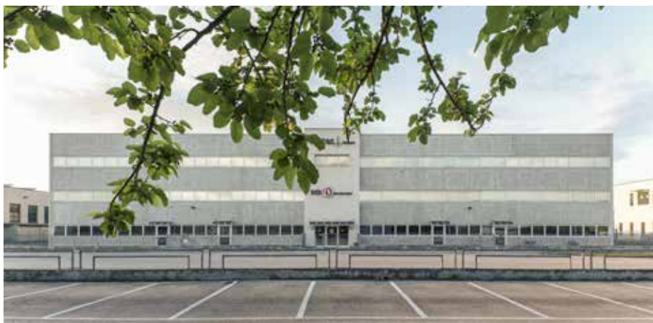
Sede centrale di BTK - NORD ITALIA
